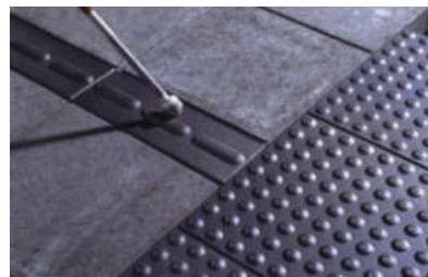
좌) 점자블록과 안내사인을 동시에 적용한 바닥형 안내사인 우) 주변환경을 배려하여 이질적 색 적용을 지양하고, 질감차를 적용한 점자블록
