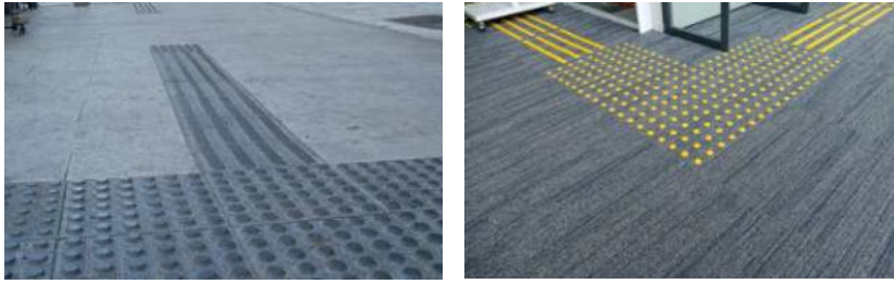
주변 바닥 마감재를 고려한 점자블록 설치
