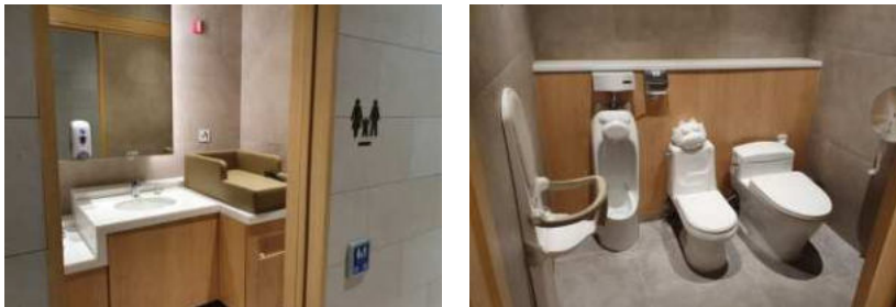
어린이용 변기 및 세면대, 기저귀 교환대 등을 설치한 가족 화장실 사례
