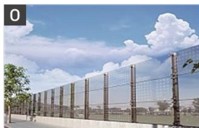
개방적 이미지의 방음벽 설치
